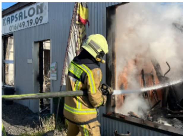
▲ Het hondenkapsalon was niet meer te redden. © Bollen
