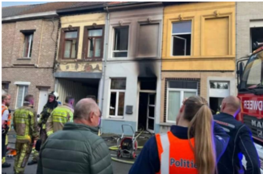
Geraardsbergen: De smalle rijwoning brandde helemaal uit. © Frank Eeckhout
